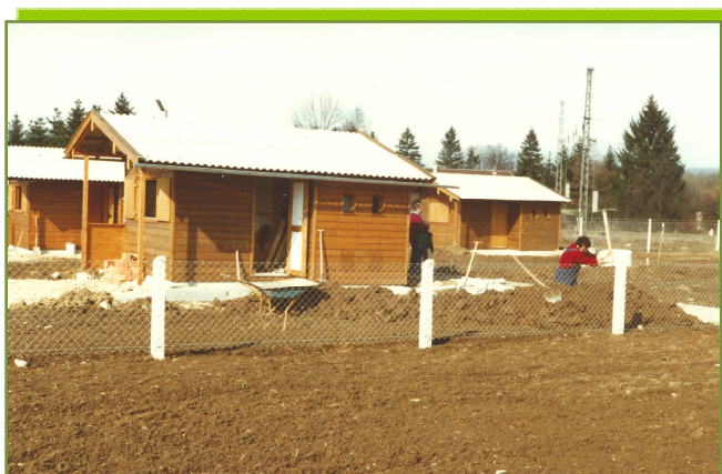
Foto: Passer / 1. Erweiterung, Rohbauten
