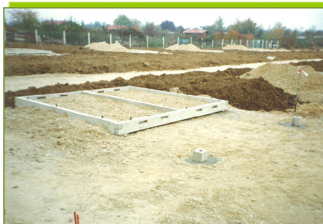
Foto: Schwarzbauer / Tiefbau ist angesagt
